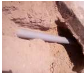
Aansluiting van de afvoer op de septische put
