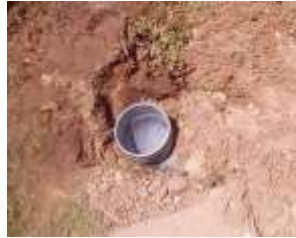
Bouw van een bassin met afvoer naar de nabije septische put
