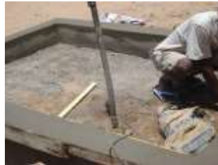
Bouw van een bassin met afvoer naar de nabije septische put
